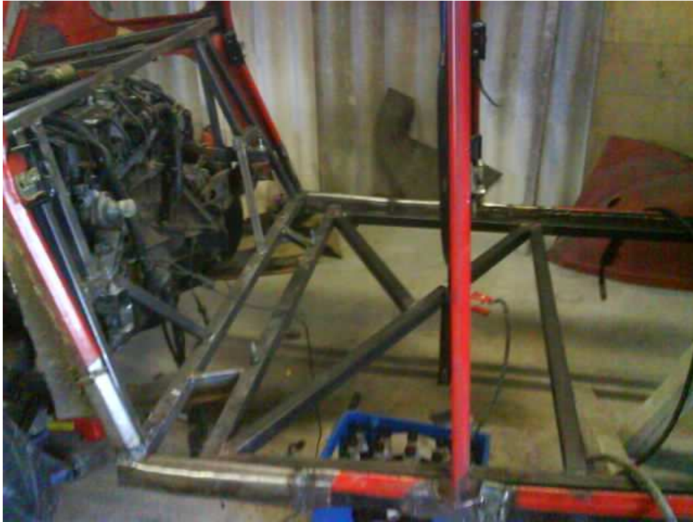
Einschweißen der Bodenverstrebung.
